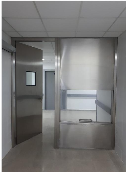
Las puertas situadas en esta área de **Nivel Crítico** de PCI se encuadran en los niveles de seguridad del área de Ucis y Aislados, cumpliendo con requisitos como Hermeticidad, Materiales Antibacterianos, Control de Acceso, Equipo de respaldo para 200 ciclos. Se utilizan más las corredizas con las mismas características y bajo las mismas normas y clasificación que en el nivel anterior, incluyendo además:
