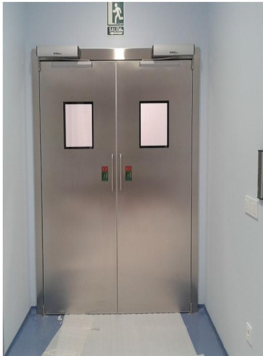
Las puertas situadas en esta área están en el **Nivel 3**, 3° Filtro de PCI se encuadran en los niveles de seguridad radiológica y contaminación. Normalmente son abatibles en radiología y corredizas en área sucia para eliminar las turbulencias que producen las puertas abatibles.
